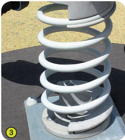
3- **Die Federn** sind aus Stahl 35 SCD 6. Die Oberflächen sind nach dem Sandstrahlen vorgespannt und mit einer Zinkgrundierung sowie zwei Schichten Epoxidharzpulver von 100 Mikron versehen. Die Halterung (Proludic-Patent) ist aus Polyamid. Dadurch ist das System langlebig und außergewöhnlich sicher.
