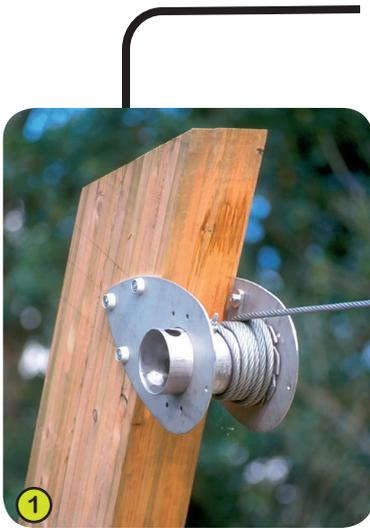
1- **Die geschwungenen Standpfosten der Seilbahn** sind aus 95 mm dickem, 200 mm breitem und 3,2 m langem, lasiertem und kesseldruckimprägniertem Leimbinder. Dadurch ist das Spielgerät sehr solid. Die Standpfosten sind mit Pfosten-schuhe aus Metall verankert. Mit einer Ratsche kann man die Spannung des 10 mm dicken, verzinkten Drahtseils auf einfache Weise einstellen.
