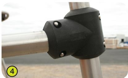
10- **Die Schrauben und Muttern** aus Edelstahl sind zum Schutz gegen Vandalismus durch Schutzkappen aus Polyamid abgedeckt.
