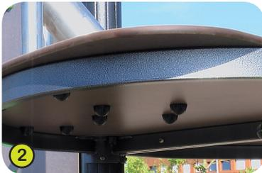
2- **Die Standflächen der Plattformen** sind aus 12,5 mm starken, an der Oberfläche rutschfest strukturierten, Harzkompositplatten (HPL), verstärkt durch Unterzüge aus verzinktem Stahl.
