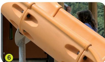
6- **Die Kayak-Rutschflächen** sind aus rotationsgeformtem Polyethylen hergestellt.
