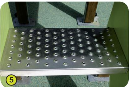
5- **Die Treppenstufen** sind aus abgekantetem Aluminiumriffelblech. Das macht die Treppen robust und langlebig.
