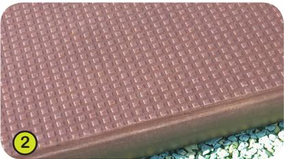
2- **Die Standflächen der Plattformen** sind aus 12,5 mm starken, an der Oberfläche rutschfest strukturierten, Harzkompositplatten (HPL), verstärkt durch Unterzüge aus Stahl.
