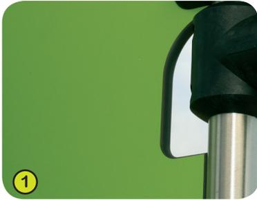
1- **Die farbigen Platten** bestehen aus Trespa-Harzkompositplatten, 13 mm stark. Sie werden auf Basis thermohärtender Harze (30%) hergestellt, homogen verstärkt mit Holzfasern (70%), die unter hohem Druck und Temperatur verpresst werden, und dadurch besonders unempfindlich gegenüber allen Witterungseinflüssen wie z. B. Sonne, Regen, Feuchtigkeit, ... (klimatische Aggressionen) sind.
