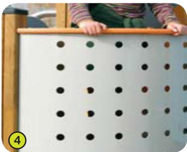
4- **Die Balkonbrüstungen** sind aus 3 mm dickem, perforiertem, epoxidharzbeschichtetem Aluminiumblech.
