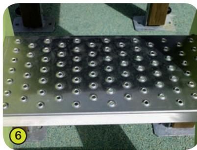
6- **Die Treppenstufen** sind aus abgekantetem Aluminiumriffelblech. Das macht die Treppen robust und langlebig.
