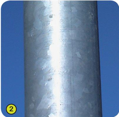
2- Der **Pfosten** mit 114,3 mm Durchmesser ist aus verzinktem Stahl.
