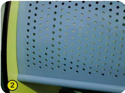
2- **Die Dächer** sind aus 3 mm dickem, perforiertem, epoxidharzbeschichtetem Aluminiumblech.
