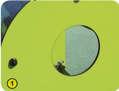
1- **Die farbigen Platten** bestehen aus Trespa-Harzkompositplatten, 13 mm stark (HPL). Temperatur- und witterungsbeständig, widerstandsfähig gegen Vandalismus.
