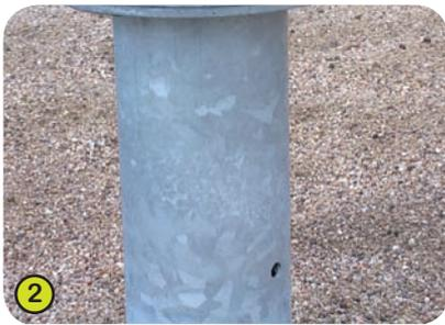
2- **Die Standpfosten** mit 90 mm Durchmesser sind aus verzinktem Stahl.
