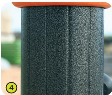
4- Die **Standpfosten** mit 125 mm Durchmesser sind aus verzinktem, lackiertem Stahl. Die in zwei verschiedenen Grautönen hammerschlaglackierte Oberfläche hat ein leichtes Profil und ist so weitgehend unempfindlich gegen Kratzer.
