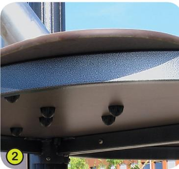
2- **Die Standflächen der Plattformen** sind aus 12,5 mm starken, an der Oberfläche rutschfest strukturierten, Harzkompositplatten (HPL), verstärkt durch Unterzüge aus verzinktem Stahl.
